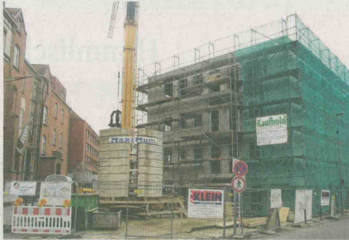
Der Rohbau des vierstöckigen Hauses an der Feldgärtenstraße ist fertig. Noch im laufenden Jahr ist die Inbetriebnahme geplant. Foto: bes
