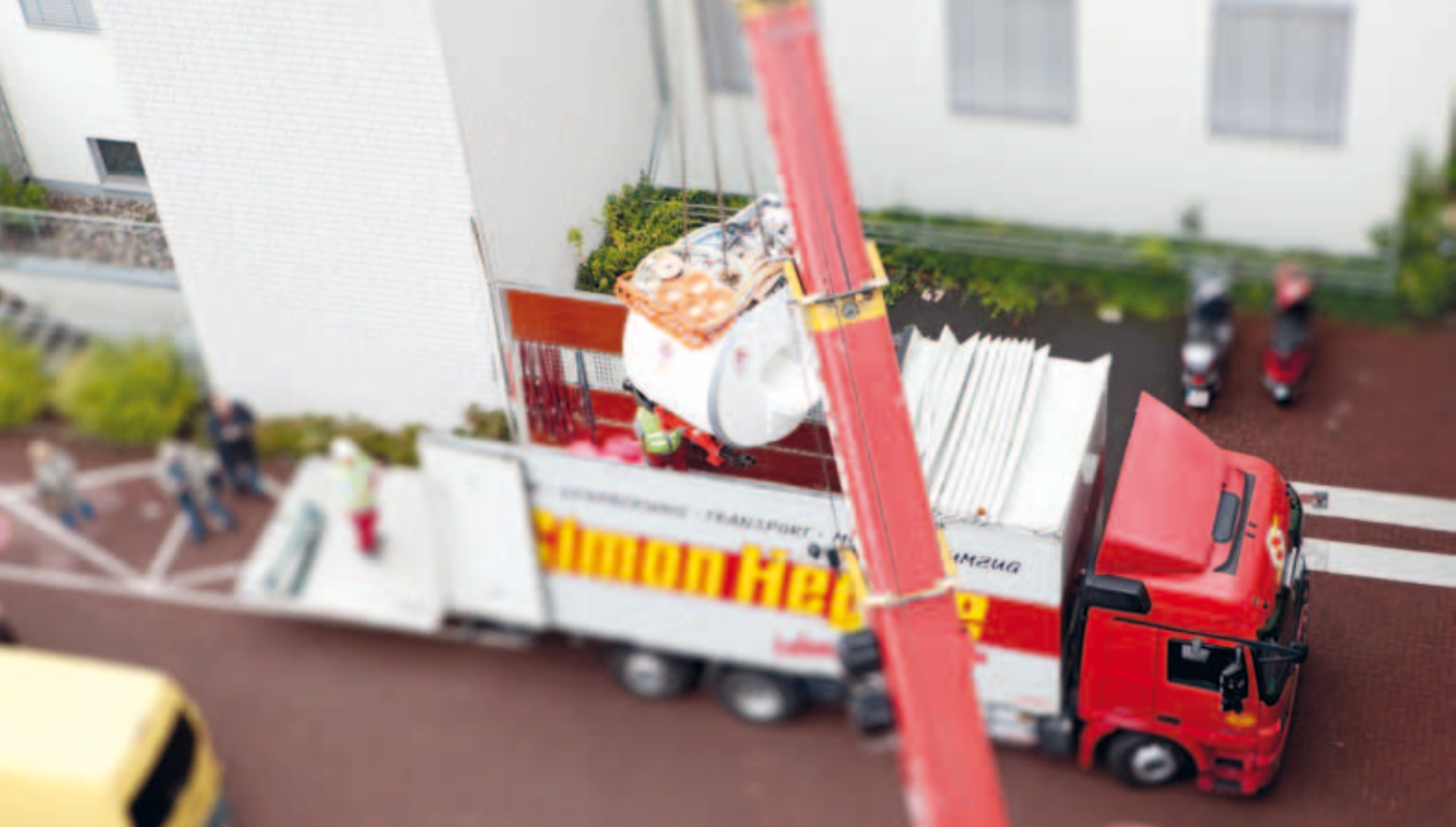
Am Haken: Schwerlastkran mit MRT
